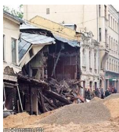
Провал мостовой и обрушение дома на ул. Большая Дмитровка
